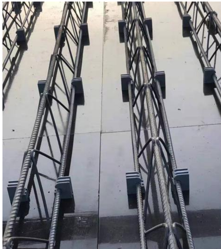
装配可拆式钢筋桁架楼承板
