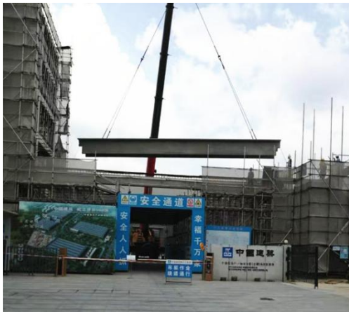
预应力混凝土双 T 板工程应用图
