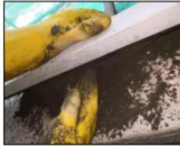
图 2 手工塞缝
