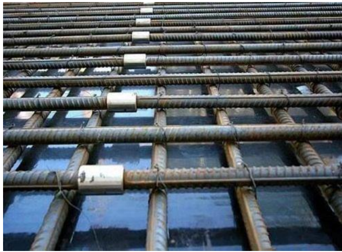
大直径钢筋直螺纹连接技术大直径钢筋直螺纹连接技术
