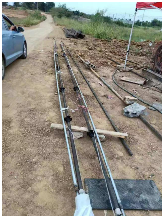
笼芯囊袋锚杆（防腐抗浮锚杆技术）
