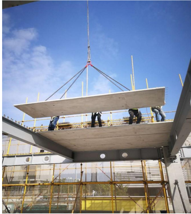
预应力带肋混凝土叠合板工程应用图
