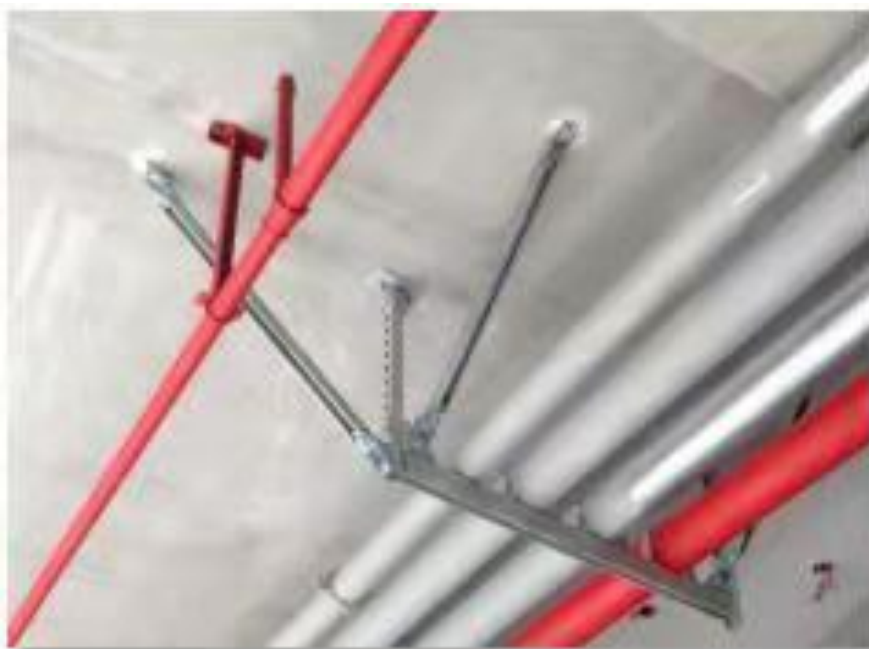
抗震支吊架工程案例
