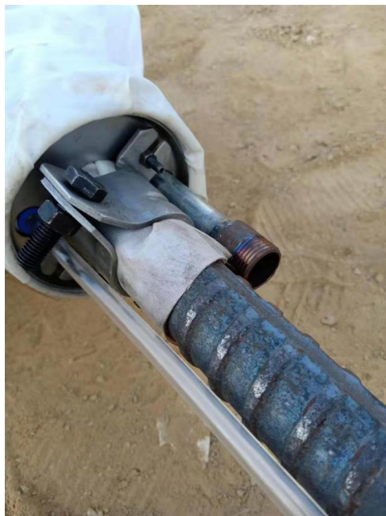
笼芯囊袋锚杆（防腐抗浮锚杆技术）
