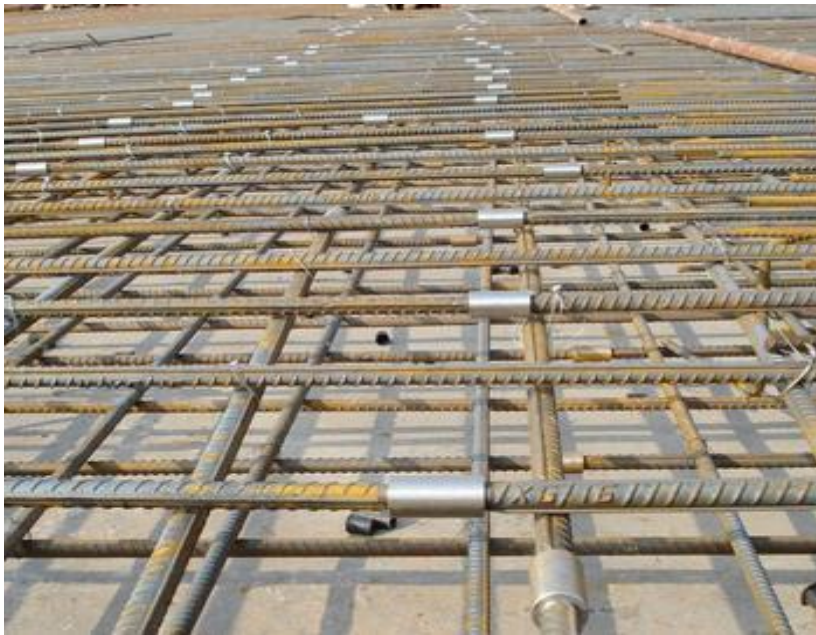
高强钢筋的套筒连接
