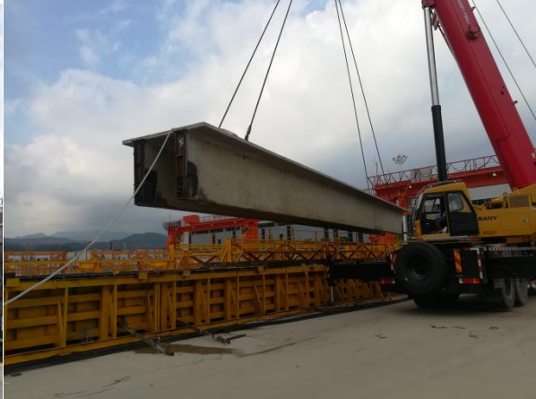
预应力混凝土双 T 板脱模起吊图
