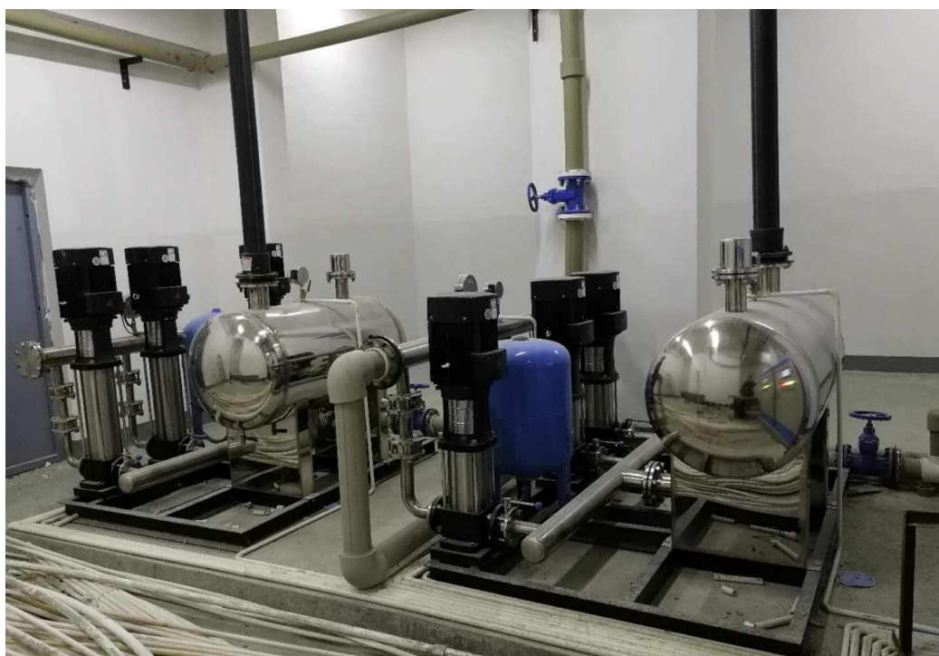
无负压管网增压稳流给水设备现场案例
